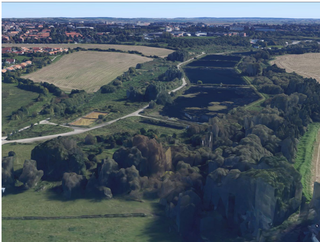
Bild 8: Västliga sidan av reningsverksdammarna nära Värpinge by med blick mot sydost. Landskapet liknar en parkanläggning i engelsk stil. Det omfattar också åkrarna på bildens vänstra sidan. Vid bebyggelse av åkrarna skulle området tappa mycket av sitt värde som rekreationsområde. (Google maps data)
